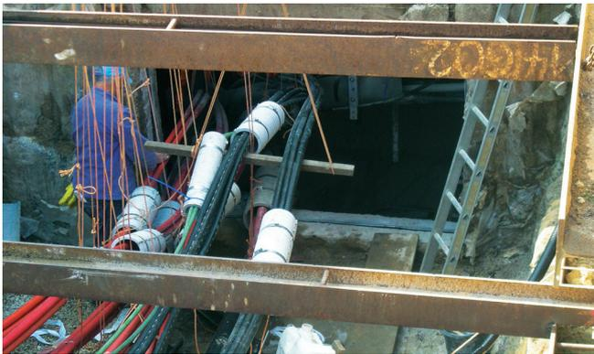
Um die verlegten Kabel und Schutzrohre wurde eine Aussparung hergestellt und um jedes Kabelsystem geteilte Futterrohre montiert.
