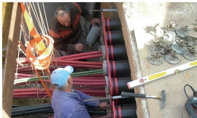
Einbau der Dichtpackungen HSI 150-K2 und der geteilten Futterrohre FZR-G.
