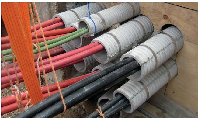
Die Kabelsysteme wurden über Seile abgefangen, um eine sichere Positionierung in der Schalung zu gewährleisten.
