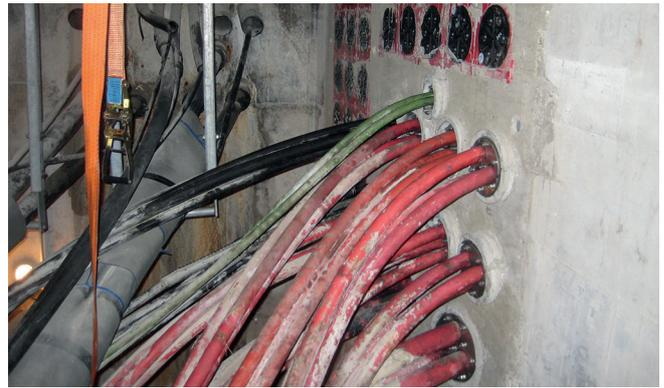
Zustand des Dükers nach der Sanierung: Reservedurchführungen wurden geschaffen. Um die verlegten Kabel wurden geteilte Futterrohre montiert. Somit war die Dichtheit von der Wand über die Futterrohre bis zu den Kabeln gewährleistet.
