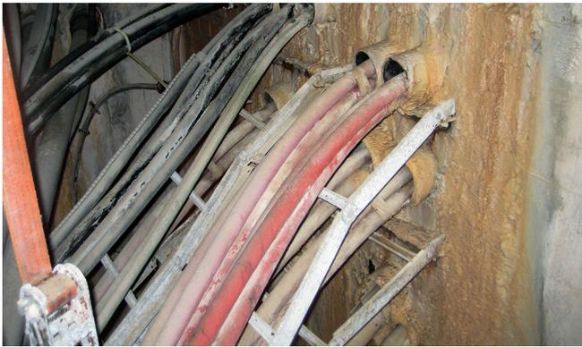
Zustand des Dükers vor der Sanierung: Wasser trat zwischen den Schutzrohren und Kabeln sowie zwischen den Schutzrohren und der Wand ein.
