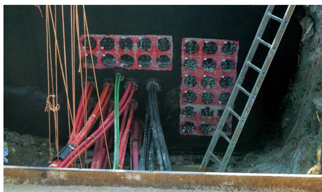
Die Dükerwand wurde mit kunststoffmodifizierter Dickbeschichtung behandelt.
